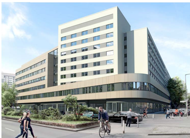
Straßenansicht Keithstraße / Kurfürstenstraße
