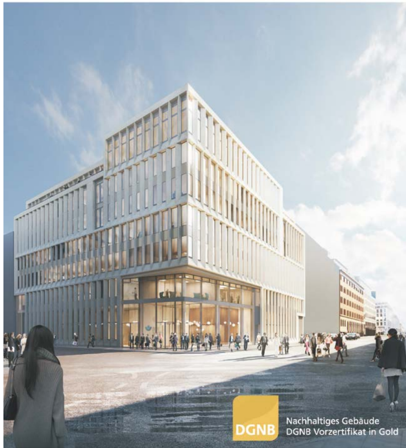
Straßenansicht Hauptgeschäftsstelle der DGUV Glinkastr. / Französische Str.
