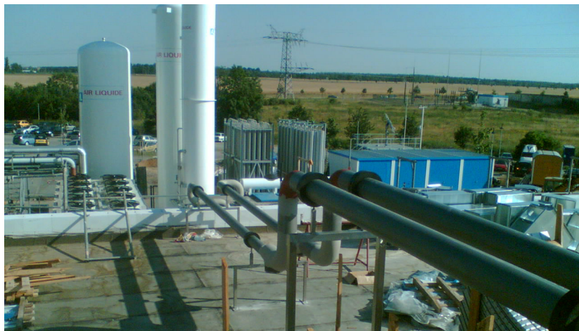
Bau des Kältenetzes zur Versorgung mehrerer Produktionslinien
