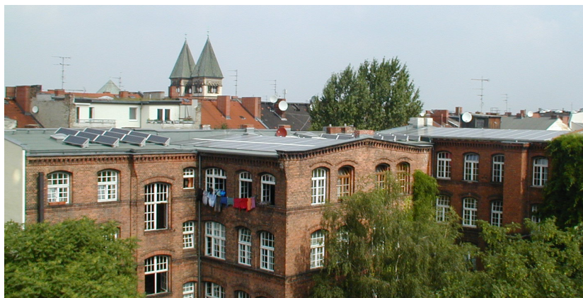
PV-Anlage mit 24 kWp
