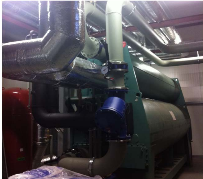
Absorptionskältemaschine 500kW
